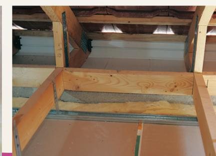
L'étrésillon de charpente bloque la laine soufflée sur l'isolant vertical pour éviter le pont thermique et vient empêcher le contact du vent avec l'isolant.
