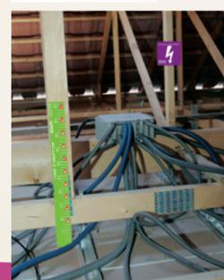
Boîtier électrique fixé hors du volume de l'isolant.
